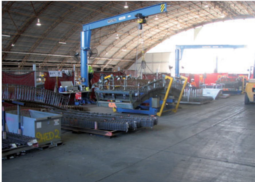
Abb. 2: Die Bewehrungsproduktion ist in einer separaten Fertigungshalle angesiedelt, die unter anderem mit zwei Schweißrobotern ausgestattet ist.
