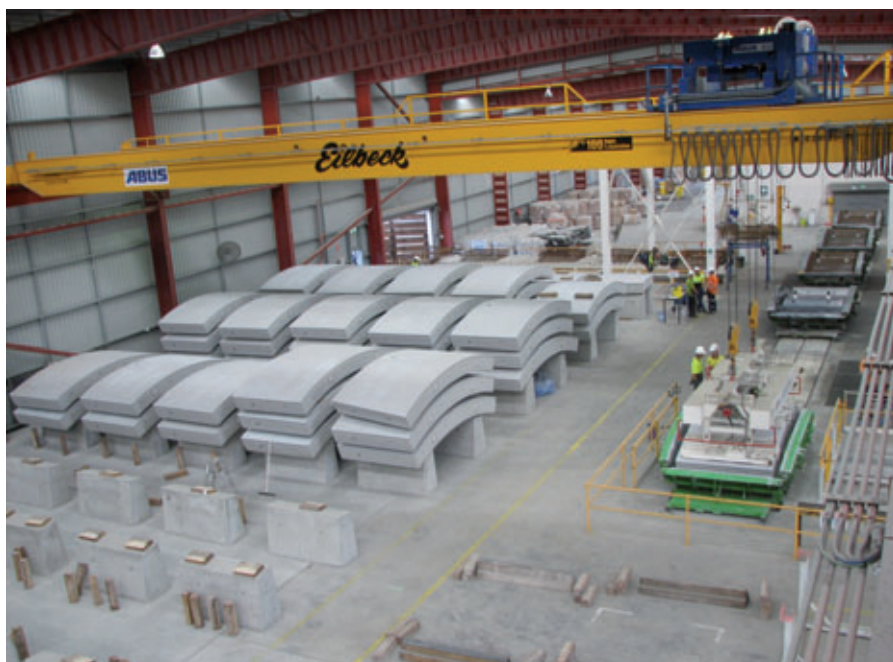
Abb. 1: Das Fertigteilwerk, in dem die Tübbingelemente produziert werden
